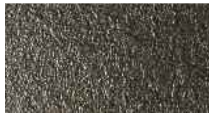
Вид под плитку
